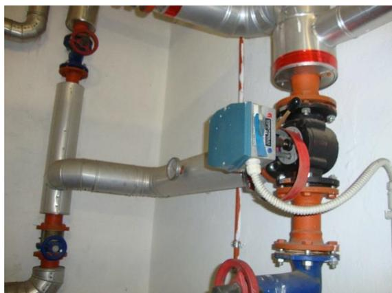
Figura 4.9 – Particolare pompa anticondensa
